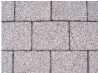
Betonpflaster mit Splittfuge
